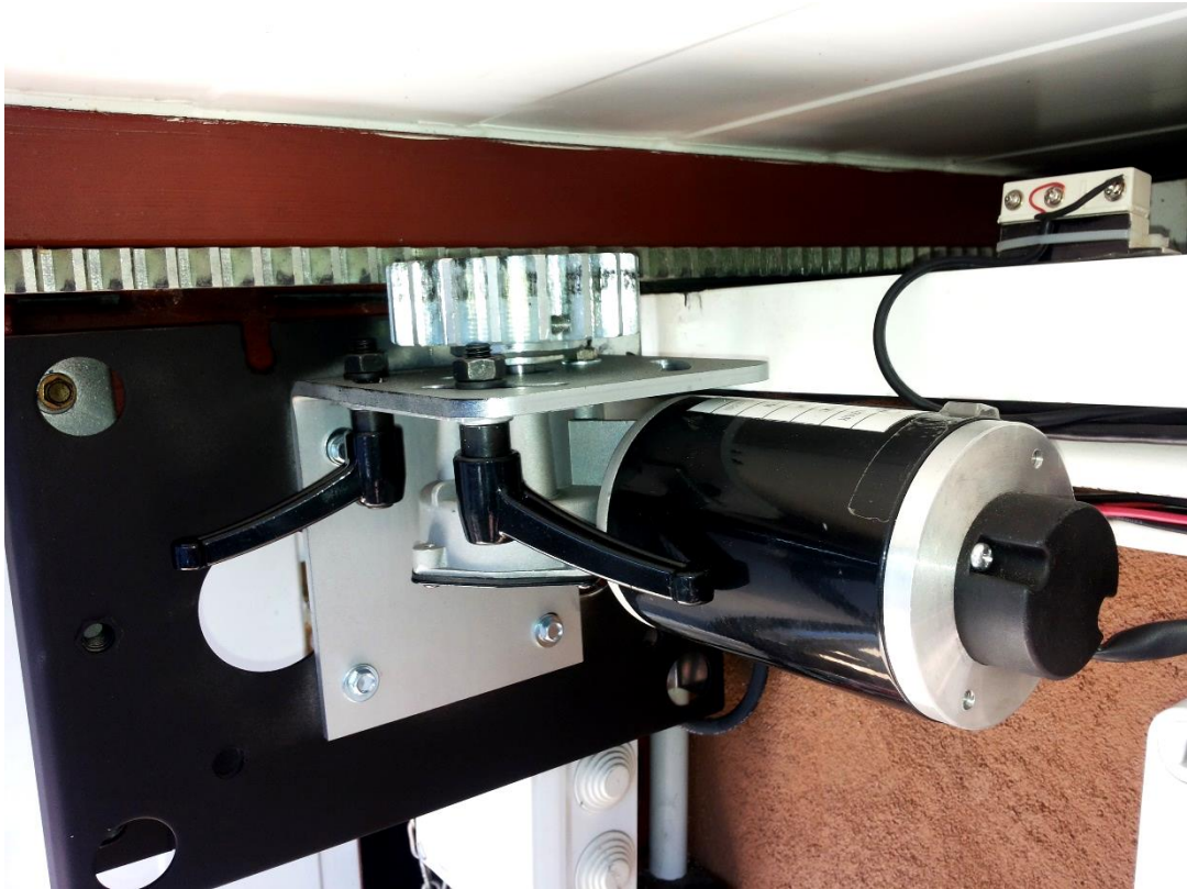
Motor y soporte con sistema rápido de desembrague
